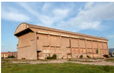
Hangar, cantiere navale Esaom Cesa
