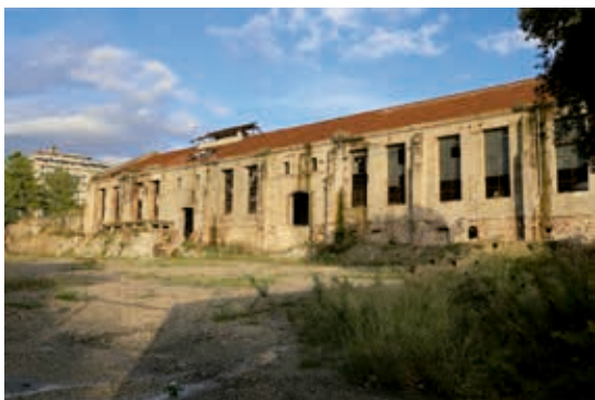
La Centrale elettrica
